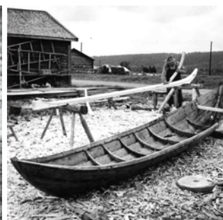
Justering av stävskarv. I förgrunden färdigbyggd trebording. Foto: Ågren, 1960
