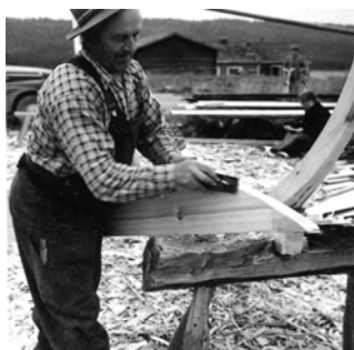
De fyra första borddelarna till första bordgången blötläggas om kvällen i Saittajärvi Foto: Ågren, 1960
