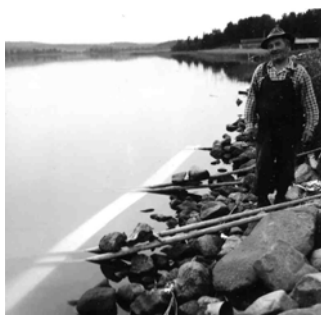
De fyra första borddelarna till första bordgången blötläggas om kvällen i Saittajärvi Foto: Ågren, 1960
